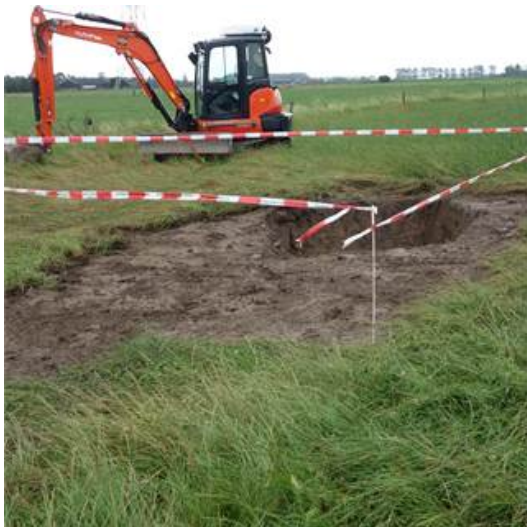
2.4 Bus sanering van olievlek in een weiland
